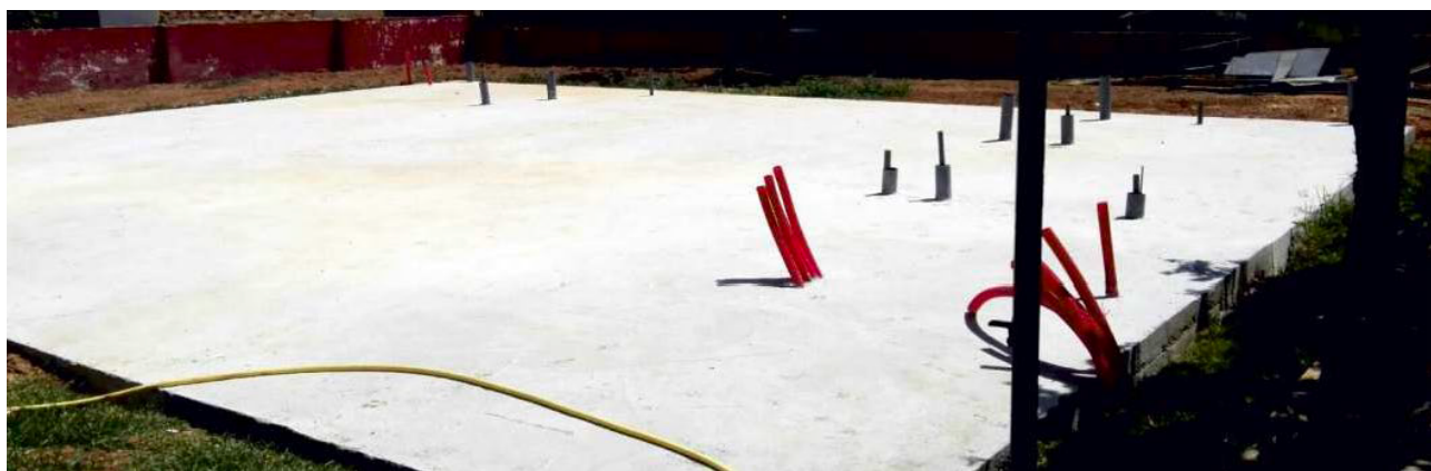
Ejemplo de cimentación por losa
